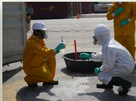
ปรับสภาพพื้นที่ด้วยกรดอ่อน
